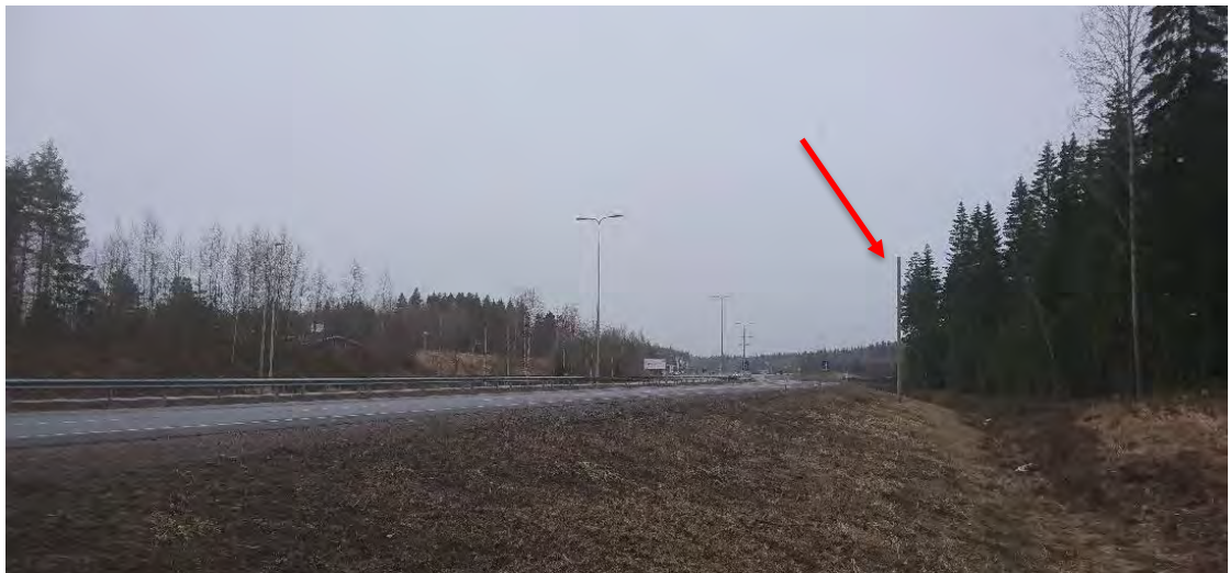
Kuva 10. Liito-oravan kulku Lahdentien yli on turvattu hyppytolpilla, mutta niiden toimivuus on epävarmaa. Nuolella on osoitettu hyppytolppa. Tiealueen leveys on noin 60 m. Oikealla kuvassa Karilan metsä C ja vasemmalla Pitkäjärven metsikkö A.
